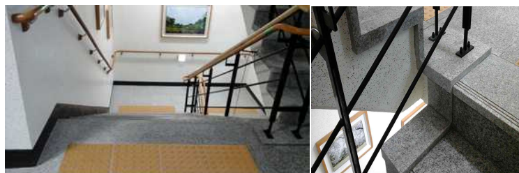
<계단 수평참 및 추락방지턱 설치 이미지>
