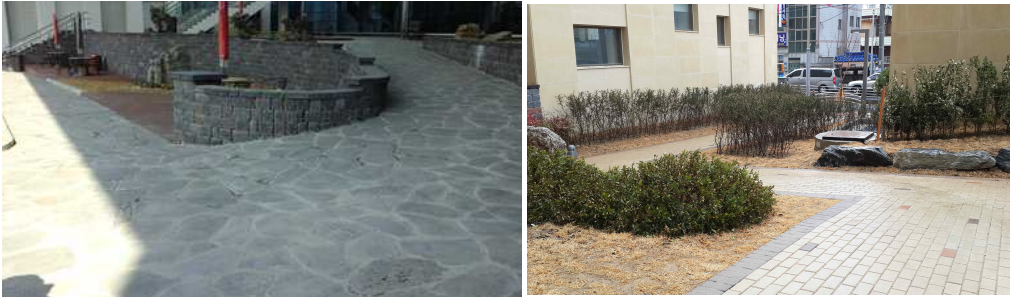
<접근경사로 수평참 미설치 사례이미지> <접근경사로 수평참 설치 사례 이미지>
