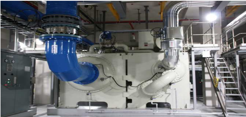
[그림 5-5-4] 서남물재생센터에 설치된 히트펌프
