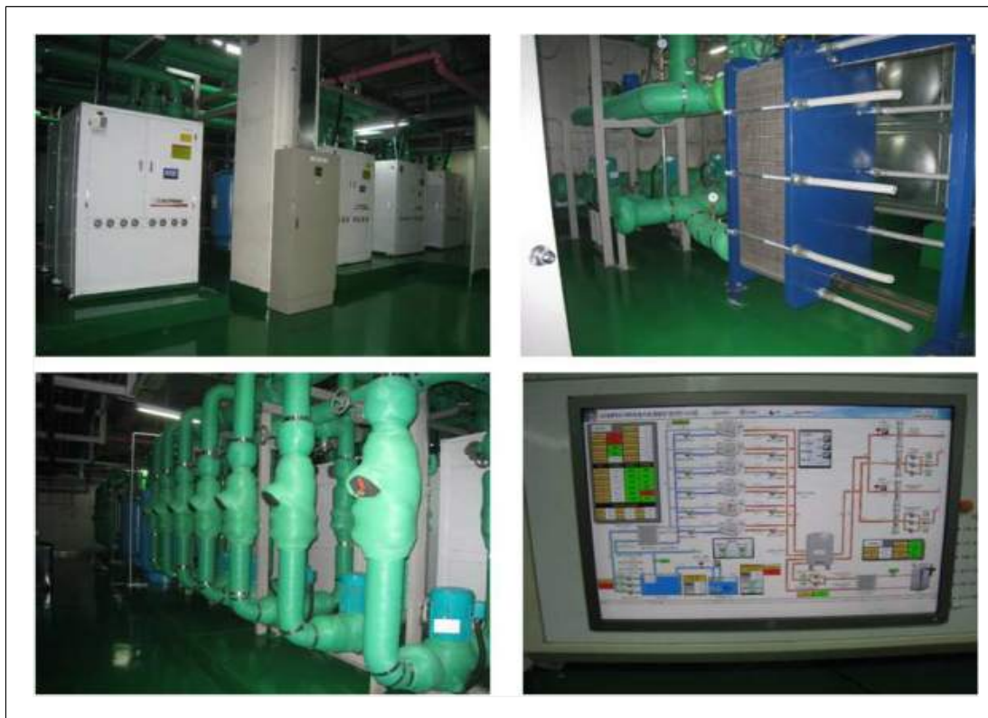
[그림 5-5-5] 고려대역사 지하수 활용 냉난방 시스템
