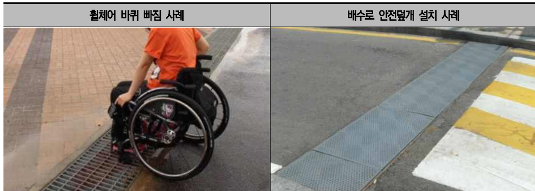
[표 5-19] 배수로 빗물받이 안전덮개 설치 예시
