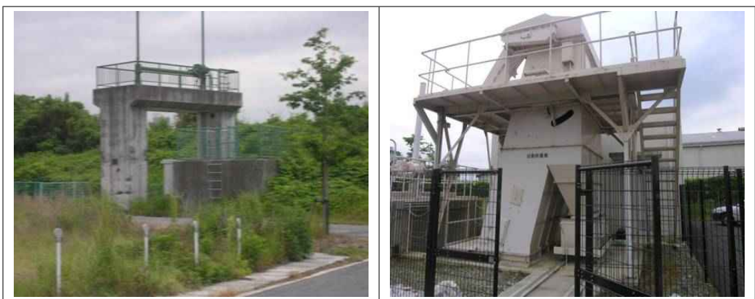
[그림 5-2-33] 일본 야마데라천(山寺川) 시가지 배수정화 모습(강우유출수 유입구와 스크린시설)
