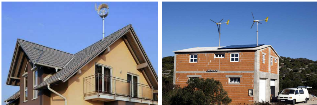
[그림 V-16] 건축물에 부착된 소형풍력설비
