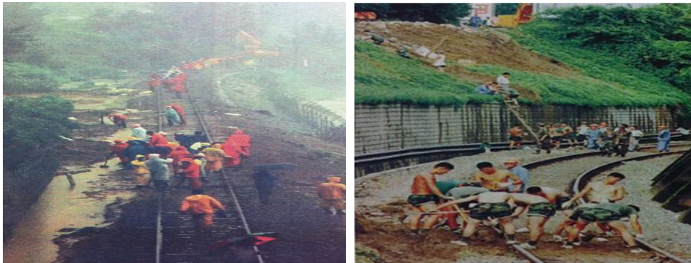
<그림 4-1-10> 집중호우로 발생한 산사태로 인해 매몰된 철로 복구작업 모습 자료 : 강원일보 (98.8.7)
