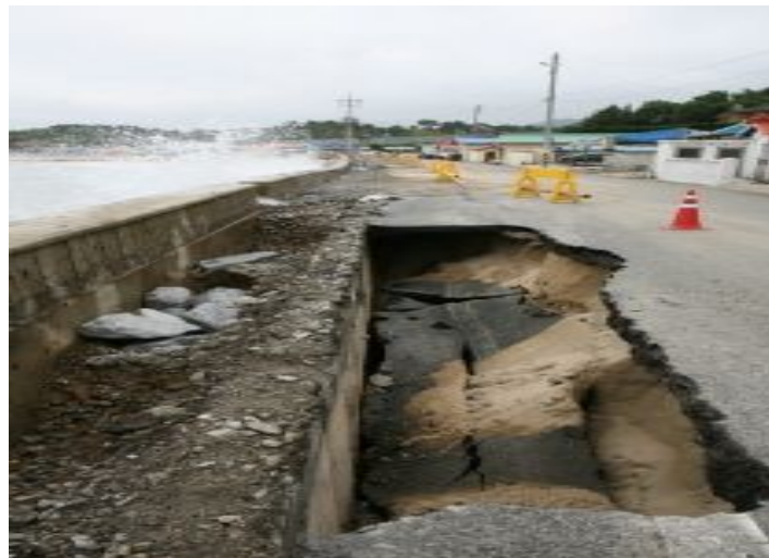
<그림 4-1-25> 양양군 현남면 남애1리 마을 앞 연안침식에 의한 도로 침하 모습 자료 : 강원일보(07.5.31)
