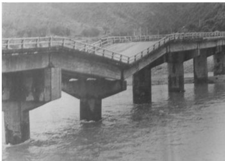
<그림 4-1-9> 홍천군 서면 반곡교 교각 피해 모습 자료 : 강원일보(92.8.28)
