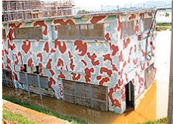
〈그림 2-65〉 달성군 화원읍 화옥배수장 (배전반이 바닥위 30cm에 설치되어있어 침수후 작동불능상태에 도달)
