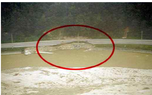
하천 세굴에 의한 도로 붕괴(1)
