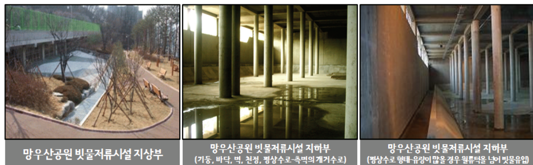
〈그림 5.67〉 빗물저류시설 설치
