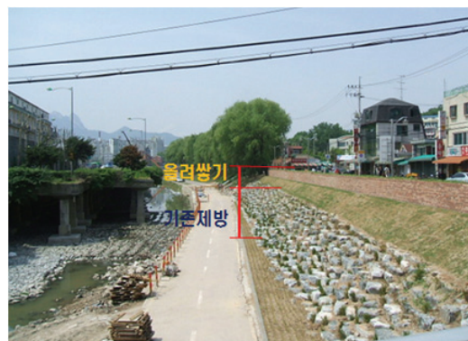
〈그림 5.28〉 하천 제방 보강사례(우이천)
