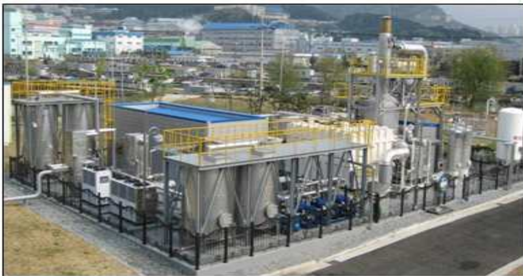
<그림 V-35> 강변하수처리장 바이오가스 연료전지 발전기 모습
