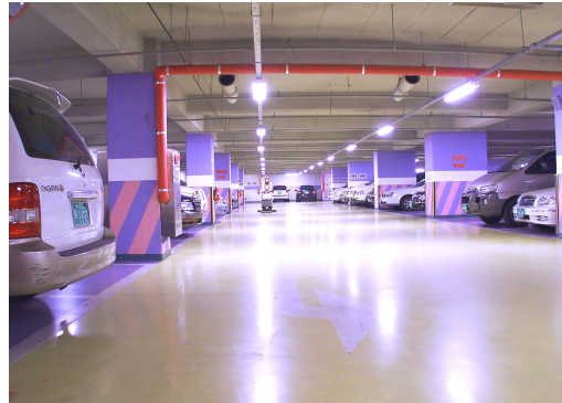
〔 지하주차장 조명 및 CCTV 설치 예시 〕
