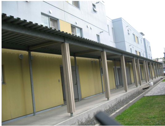
<사진1> 주출입구와 대로변까지 눈이나 비가 와도 거주자들의 이동이 편리하도록 설비된 외벽지붕. 북해도 지역 공영주택디자인의 대표적 모델이 됨.
