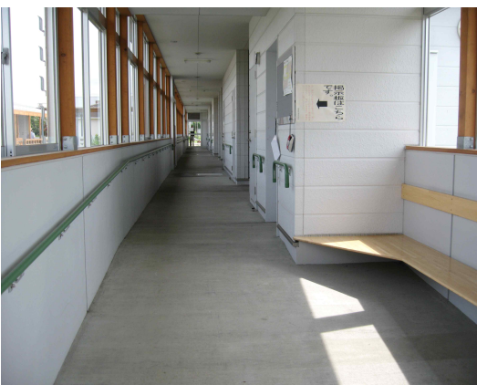
<사진18,19> 고령자의 이동이 편리하도록 단지 내 손잡이 설치 및 고령자용 미닫이 현관
