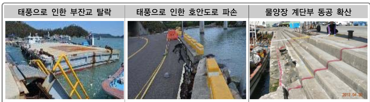
〈그림 4.83〉 노후화 및 태·폭풍 피해에 따른 시설물 긴급보수 사례
