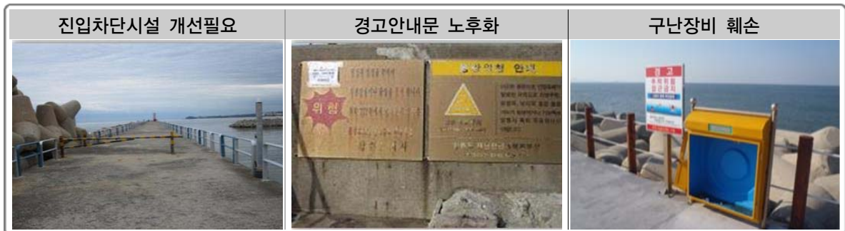
〈그림 4.86〉 어항 안전시설물 파손 및 방치사례
