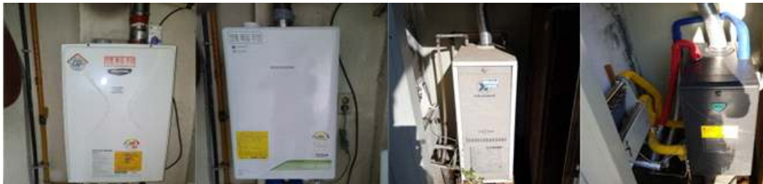
< 기존 보일러 확인 → 보일러 철거 → 보일러 교체 설치 > (왼쪽부터 가스보일러 시공 전/후, 기름보일러 시공 전/후)
