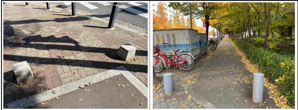
[ 그림 5-21 ] 볼라드 비규격 설치 사례
