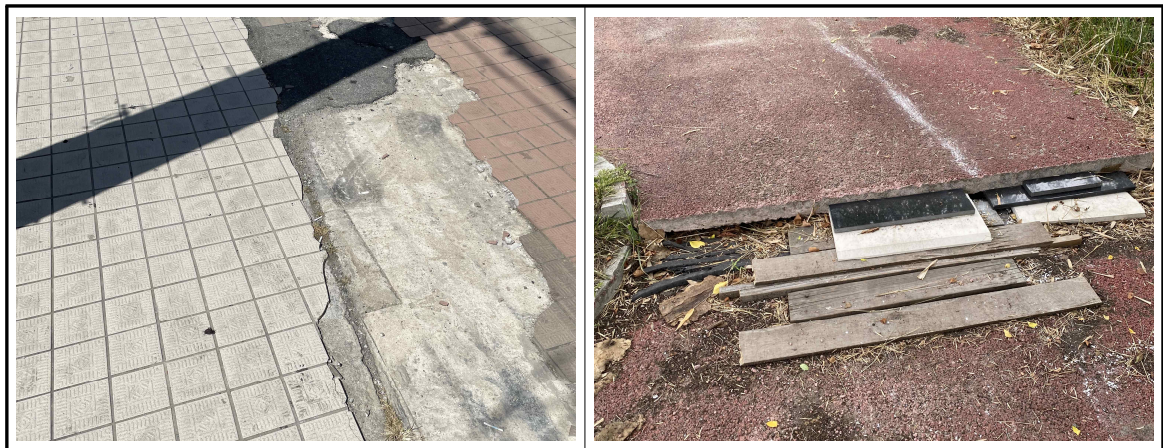
[ 그림 3-17 ] 포장상태 불량사례(무진대로 및 북문대로)
