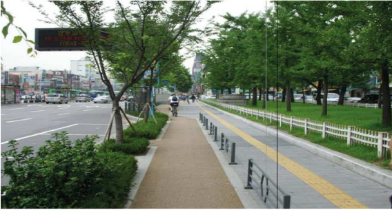
설치기준에 맞추어 유효폭과 시설한계, 위치(차도-장애물존-자전거도로-보도순)로 설치된 경우
