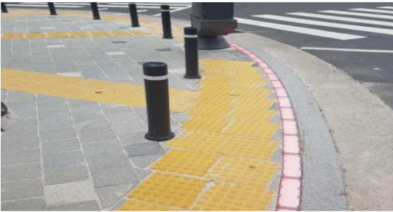
횡단보도 경계부가 곡면인 경우 점자블럭은 횡단보도와 동일한 각도를 유지하고 사이 간격이 벌어지지 않도록 설치
