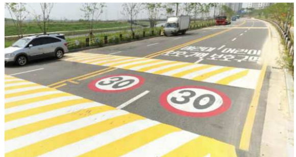
어린이 보호구역 노면 표시 및 과속방지 차도표장(지그재그패턴), 감속표지 등이 기준에 맞게 설치
