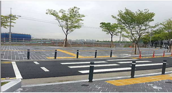
횡단보도 내 전면경사로와 점자블럭 및 볼라드의 설치기준을 준수하여 설치한 경우
