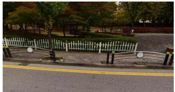
어린이보호구역 도로표지판 및 안전웬스 설치가 기준에 맞게 설치되어 있지 않은 경우
