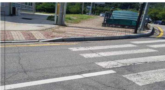
휠체어·유모차 이용자를 위한 경사로의 위치가 횡단보도 구역 내에 설치되지 않아 보행자의 안전을 위협하는 경우
