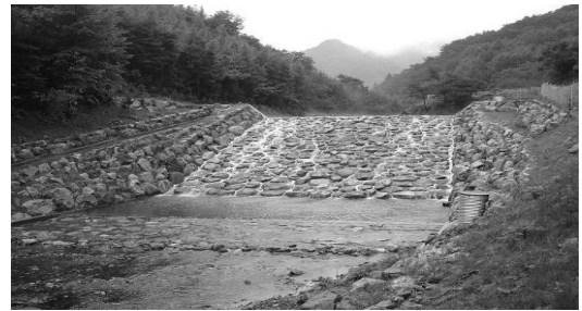
[그림 5-3-17] 사방댐 설치 사례-사천시
