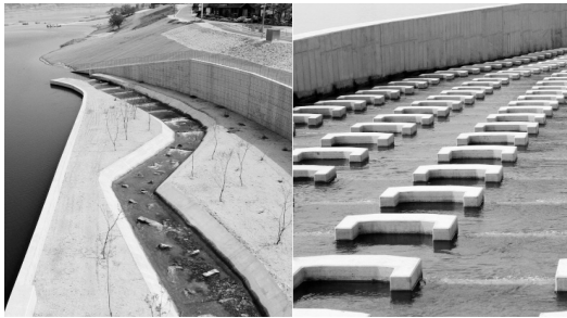
[그림 5-3-32] 제외지 하천정비-어도설치 사례
