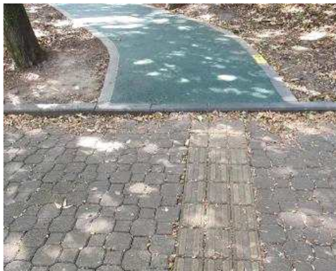
[그림 6-50] 신산공원 산책로 턱 낮춤 및 유도블록 설치
