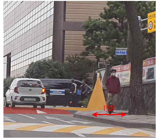
[그림 6-97] 전농로 보도 폭 확보 및 고원식 횡단보도 설치
