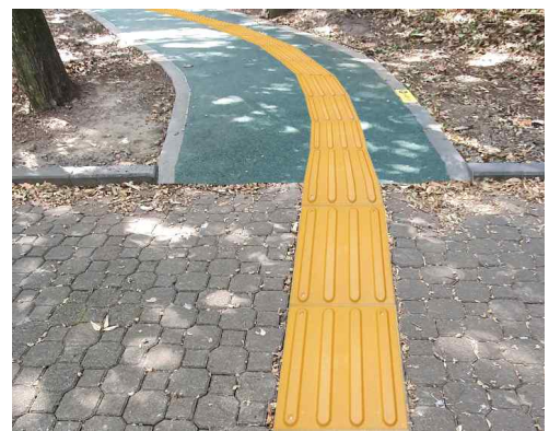
[그림 6-50] 신산공원 산책로 턱 낮춤 및 유도블록 설치
