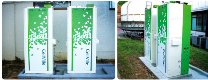
[그림 6-17] 서울대학교 내 연료전지 2kW 용량 설치 사례
