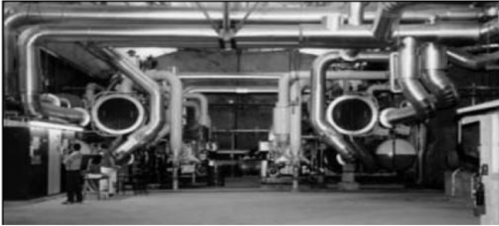
<그림 V-5-11> 오슬로 하수열원 이용 지역냉난방 시스템
