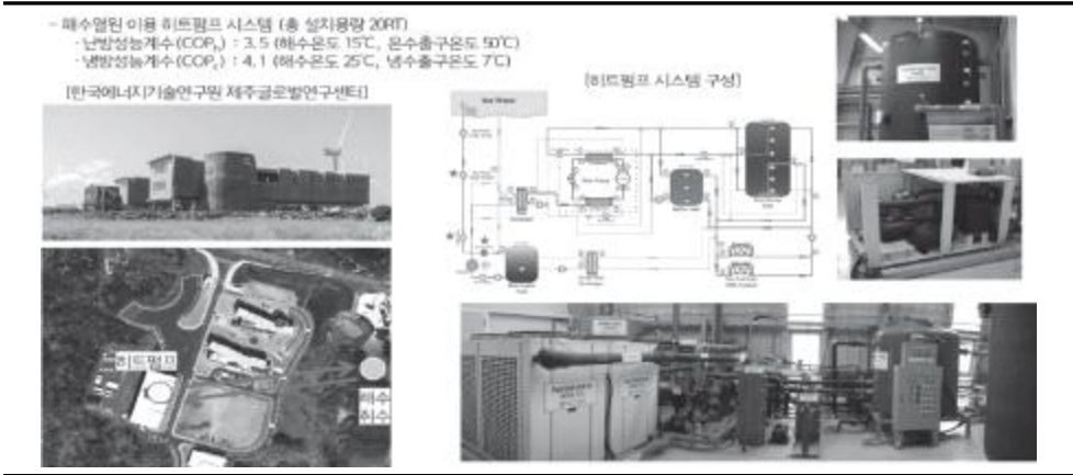
〈그림 V-5-6〉 해수열 이용 히트펌프 시스템
