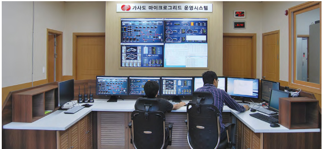
〈그림 V-10〉 가사도 마이크로그리드 운영시스템 및 EMS
